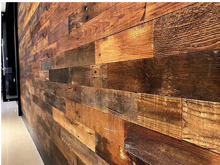
壁面に施工し、無塗装の古材スティックの上からナチュラルオイルを塗っています。
